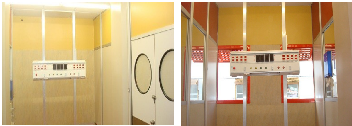
Vistas de salas de terapia intensiva en obra
